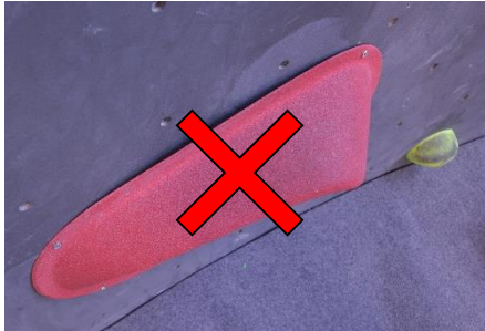
Bild 4 Unzulässige Befestigung an einer konkaven Wand
